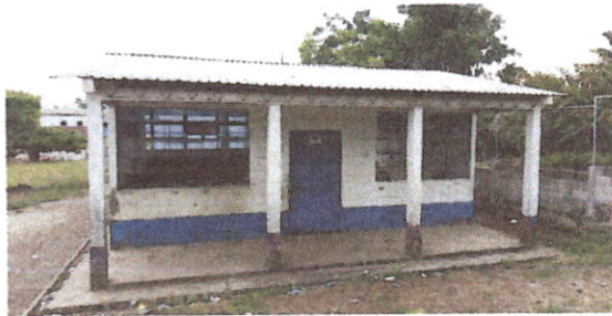
FOTO 1: Sustitución de lamina, por lamina troquelada calibre 26
