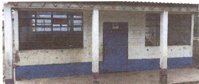
FOTO 4: sustitución de balcones de metal por metal.
