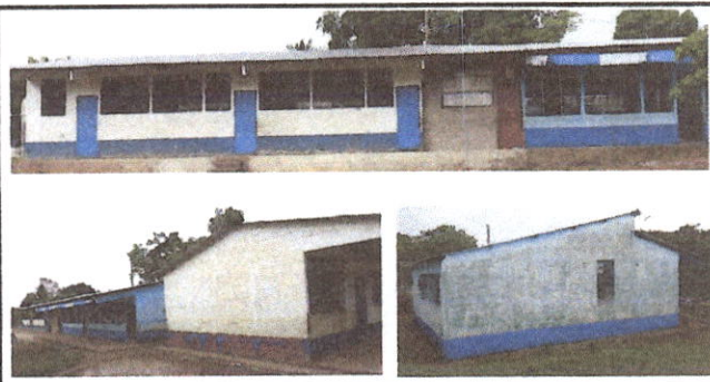
FOTO 6: Pintura de muros exteriores.
